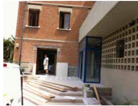
fig.3 - immagini di cantiere del nuovo ingresso
