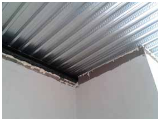
fase di cantiere - alcune immagini delle lavorazioni
