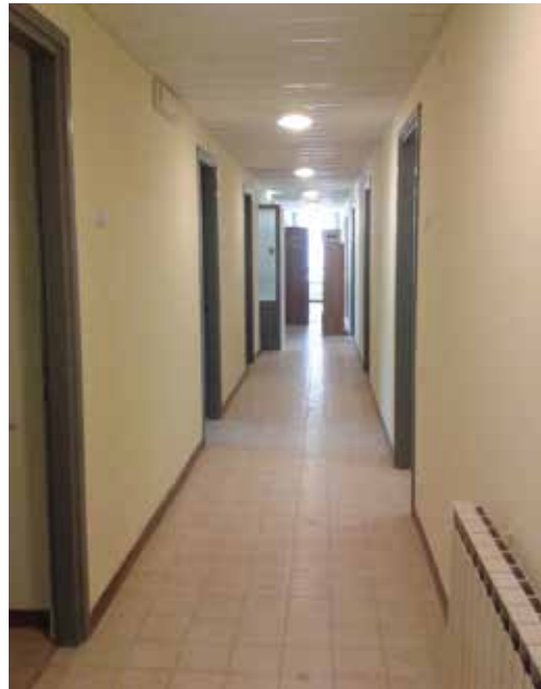
evoluzione del cantiere fino ad opera completata
