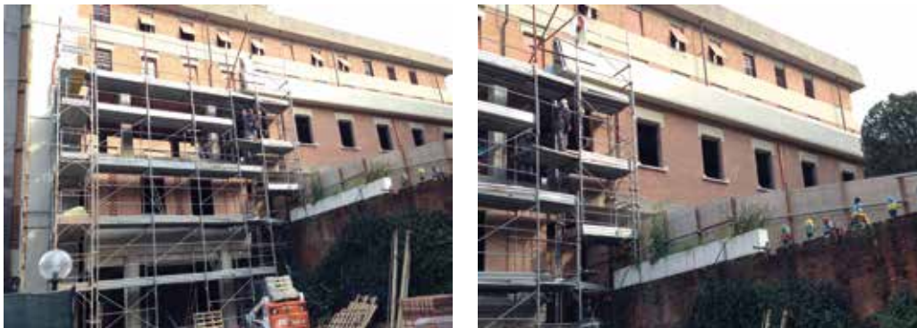
fig.1 - immagine di cantiere dell'ampliamento della scuola materna (Piano Casa)
