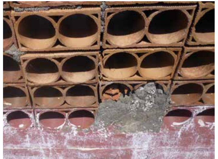
immagini del cantiere
