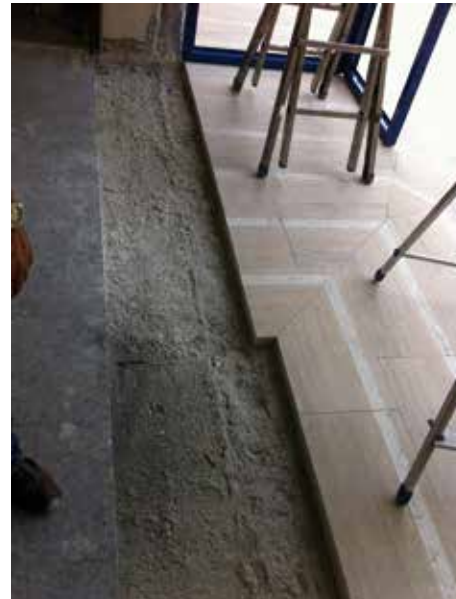
immagini di cantiere, ristrutturazione degli interni
